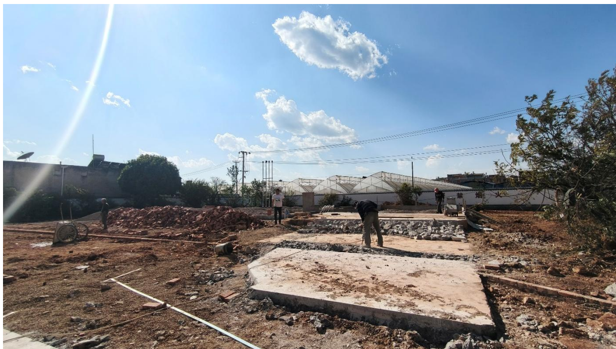
图 3 加油站储罐区（北面）
