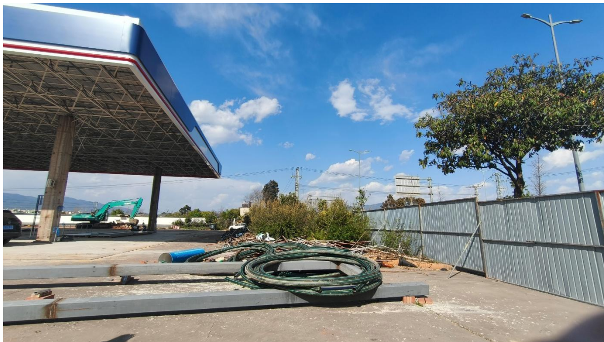
图 5 站前南面入口区域
